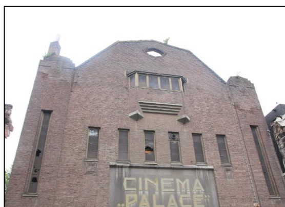
Gevel voormalige bioscoop 'Palace' (blijft behouden)
